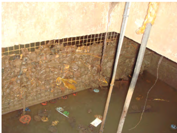
grofvuilroosters houden straatvuil tegen en beschermen lamellen voor verstopping
