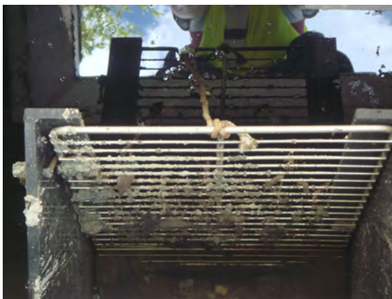
grofvuilroosters houden straatvuil tegen en beschermen lamellen voor verstopping
